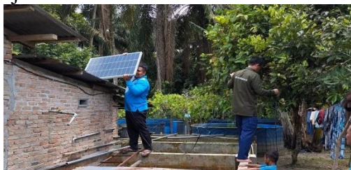
Gambar 5. Pemasangan Panel Surya Di Atap Rumah.
