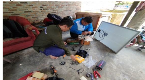
Gambar 4. Proses Perakitan PLTS
