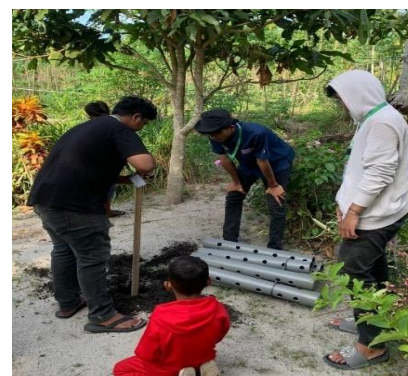
Gambar 2 Pemasangan Biopori di Rumah Warga
