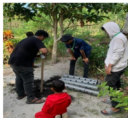
Gambar 2 Pemasangan Biopori di Rumah Warga
